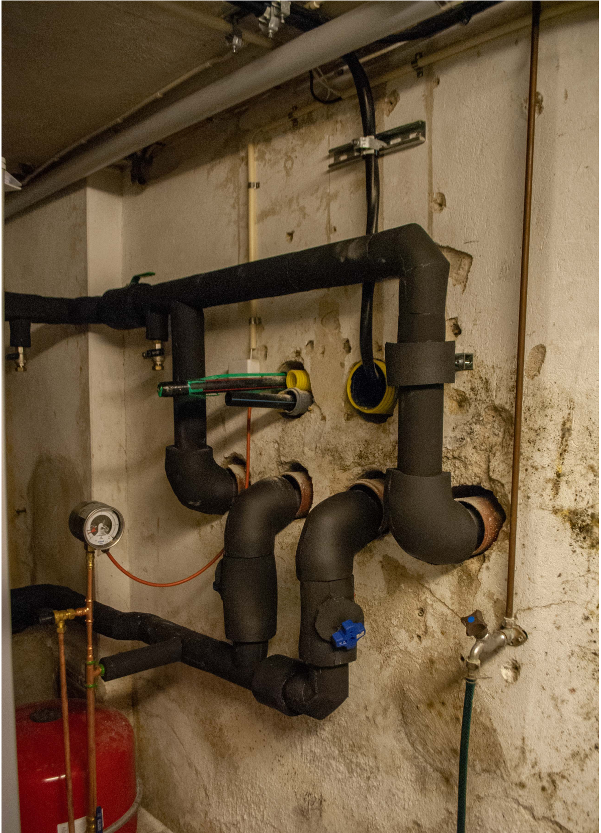
Fyra hål har tagits upp i källarväggen för bergvärmen; de tjocka svarta rören. Ett mindre hål har tagits upp för den nya elledningen; det mindre hålet till höger. Ett hål har också borrats för tomrör för framtida projekt och installationer.
